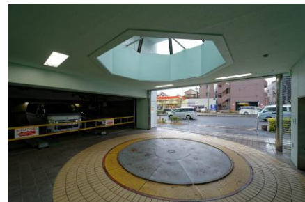
機械式駐車場
