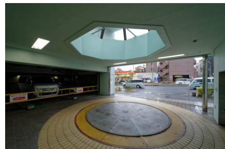
機械式駐車場
