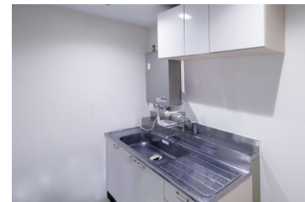
基準階共用給湯室
