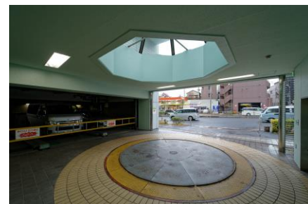
機械式駐車場
